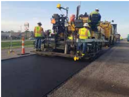
Рис. 1. Процес укладання асфальтного покриття [1]
